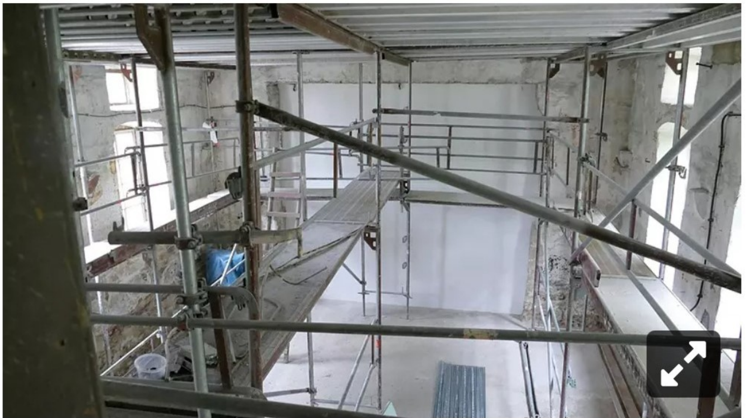
Foto: Günter Roth | Die ehemalige Synagoge von Laudenbach wird derzeit renoviert.
